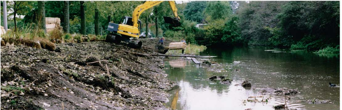
Octobre 1998 : Les terrassements sont achevés. Début de l'installation des fascines (boudins végétalisés) et géonattes.
