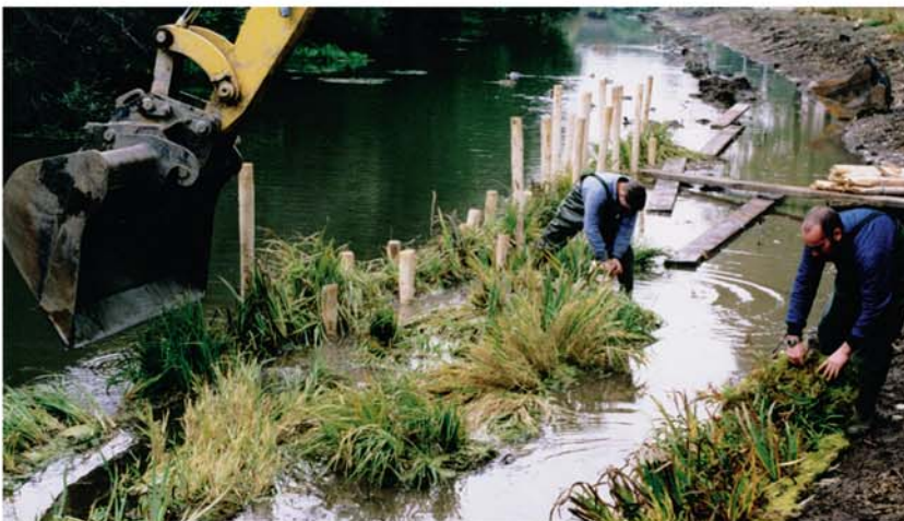
Octobre 1998 : Pose des géonattes et des fascines pré-végétalisées avec des plantes des zones humides telles que ; Iris pseudacorus, Acorus calamus, Carex, etc...
