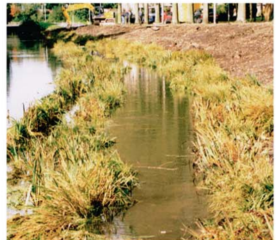
Octobre 1998 : Pose des géonattes et des fascines pré-végétalisées avec des plantes des zones humides telles que ; Iris pseudacorus, Acorus calamus, Carex, etc...
