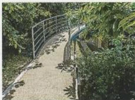
Présentant les propriétés d'un enrobé, ce revêtement extérieur drainant, à base de gravillons concassés de calcaire dur, est homogène, stabilisé et renforcé. Liant végétal organo-minéral incolore sans hydrocarbures aux performances mécaniques d'un liant hydraulique et à l'élasticité du béton bitumineux. L'évacuation des eaux pluviales limite la formation de flaques et de verglas. Pour les allées piétonnes dans les jardins, parcs, etc.
