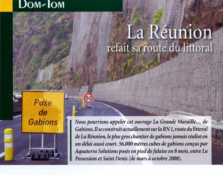
Sur 9,4 km, en complément d'immenses protections pare éboulis en filets anti sous marins doublés de grillages pare-éboulis, les entreprises présentes sur le terrain (voir encadré) réalisent un merlon pare-blocs (écran pare-pierres) de 4 mètres de hauteur moyenne par rapport au niveau de la bande d'arrêt d'urgence, soit des hauteurs totales de 5 à 8 mètres.
